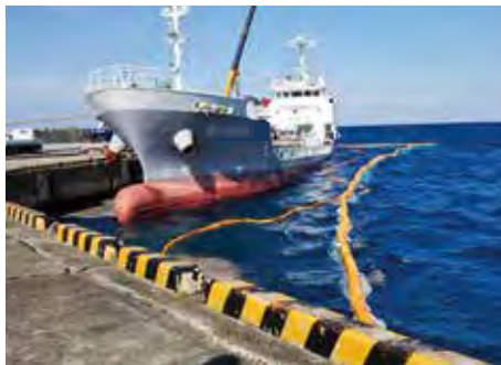
①壁全面にシルトプロテクターを設置しタンカー入港後、展張
