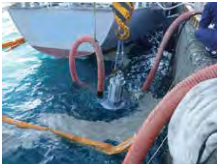
②陸上より水中ポンプを設置し水中の軽石を除去
